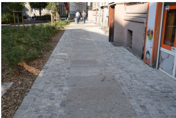
Nawierzchnia chodnika odtworzona z przyciętych historycznych płyt granitowych (strona lewa) oraz z nowych płyt granitowych (strona prawa) Obustronne pasy kompensacyjne z kostki granitowej 8-9/11 cm.
