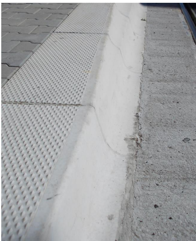
Fot. 6, 7 i 8. Przykład systemu krawędzi peronowej typu „TA”
